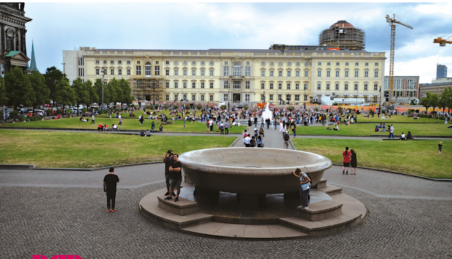
Hohenzollern-Schloss in Berlin während der abschließenden Arbeiten im Sommer 2019. Foto: Magdalena Prosińska
